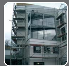
Kirchengebäude evang. Gemeinde Bonn (D) Heizleistung: 2 x 113,7 kW Wärmequelle: Wasser
