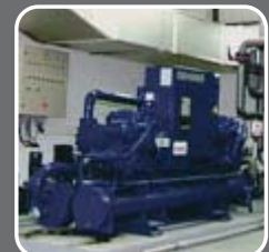
Schulkomplex Neveklov (CZ) Heizleistung: 513 kW Wärmequelle: Sole-Erdreich
