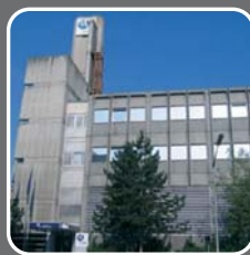
Bürogebäude (A) Heizleistung: 90 kW Wärmequelle: Kühlwasser
