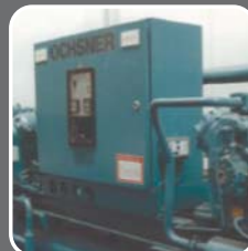
Autowaschanlage (CZ) Heizleistung: 140 kW Wärmequelle: Wasser
