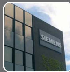
Industriegebäude Siemens München (D) Heizleistung: 140 kW Wärmequelle: Wasser
