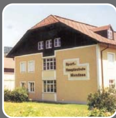
Schulgebäude (A) Baujahr: 1989 insgesamt 3000m Erdsondenlänge Wärmequelle: Sole-Wasser
